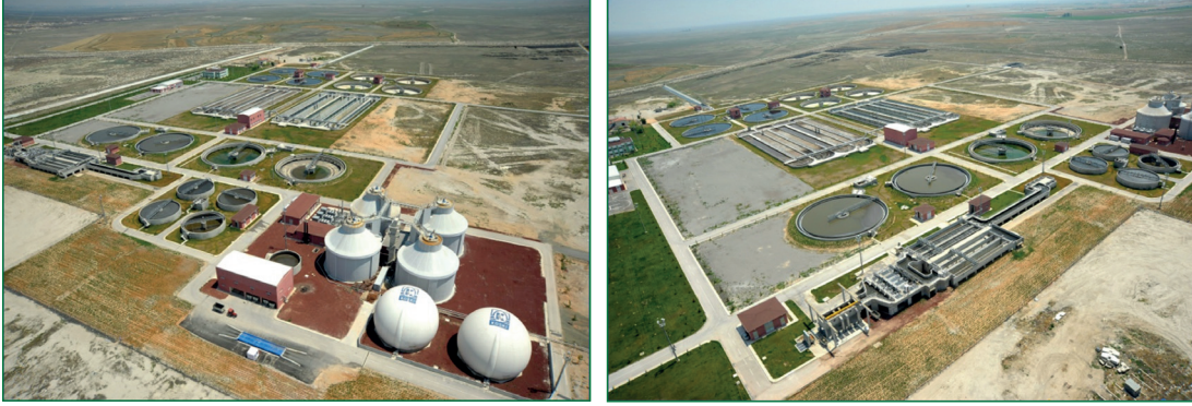
Şekil 2. Konya kentsel merkezi atıksu arıtma tesisi (KOSKİ, 2023)
