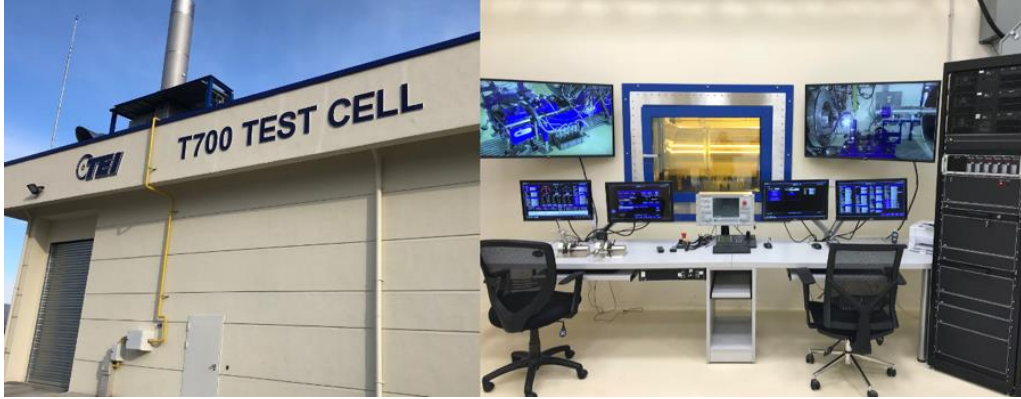
Şekil 20. TEI Eskişehir tesislerinde yerli üretim T700-TEI-701D motorlarının test ve kalifikasyonu için kurulan motor test bremzesi
